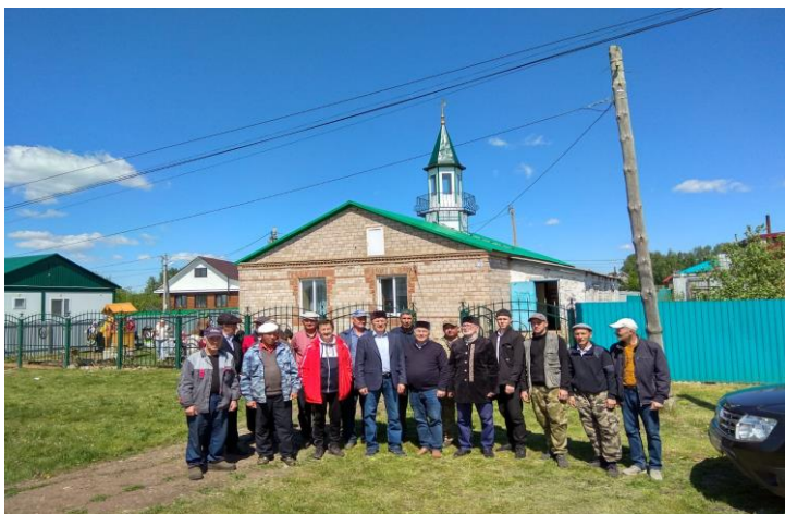
Мечеть после замены крыши и установления минарета
